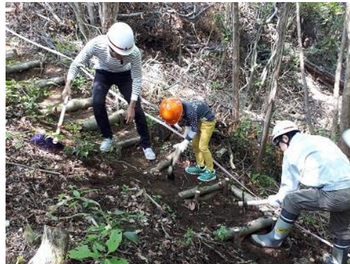
歩道整備作業
