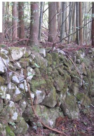
写真1 山間部に見られる斜積み（谷落とし）
