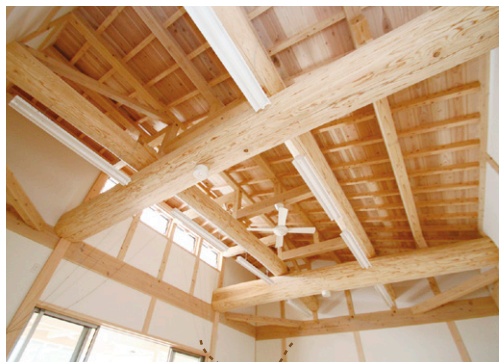
会議室の天井は、 梁・桁が見えるようになっています。
