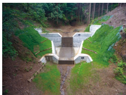
治山施設機能強化事業 権現山地区工事
