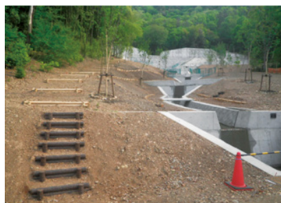
県単治山事業 第9工事
