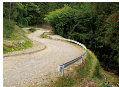
地方創生道整備推進交付金事業 相生～落部線
