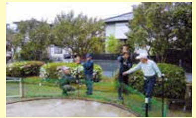
公園砂場の防猫ネット支柱補強等の様子
