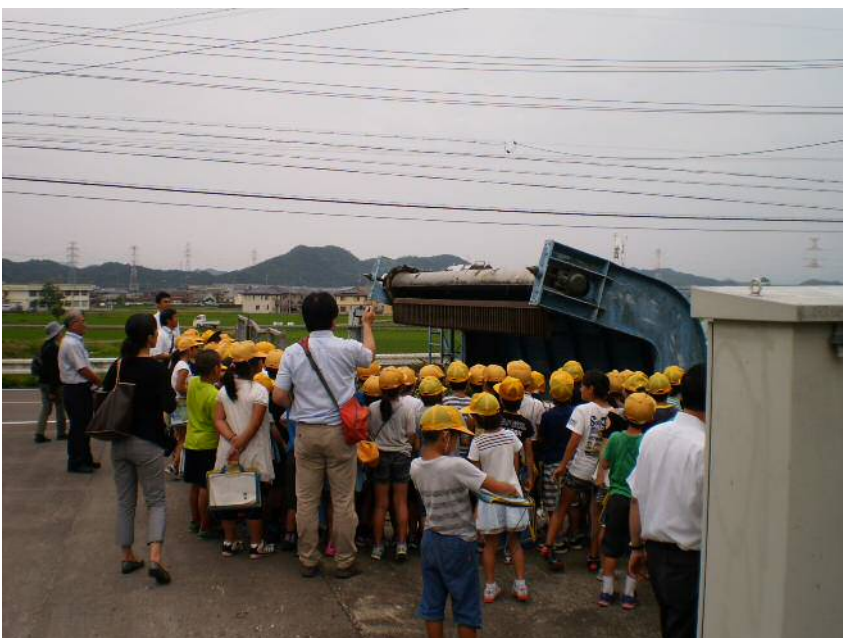
曾代水土地改良区（ じょじんき 除塵機（ゴミを取り除く機械）を見学）
