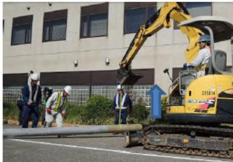
②バックホウにて電柱の片側のみを吊り上げ
