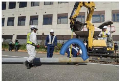
③吊り上げていない側を支点に電柱を回転させて1車線確保
