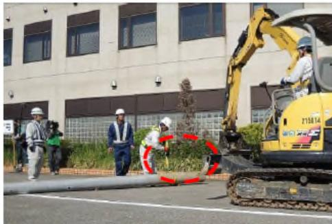
①道路啓開する車線側の電柱端に吊り用ロープを掛ける
