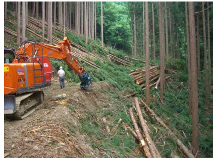
スイングヤーダ作業状況
