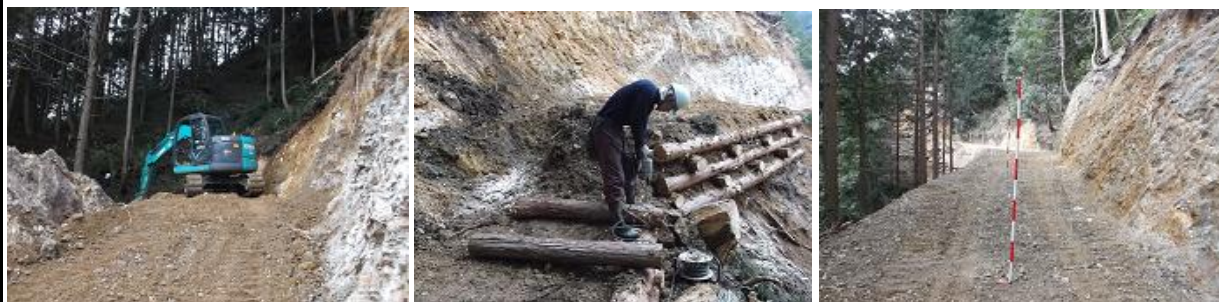
作業道の開設状況
