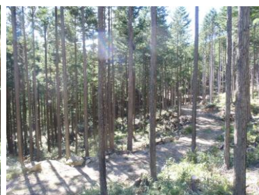
図-7 完成した森林管理路
