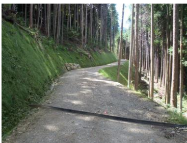
図-6 完成した基幹作業道
