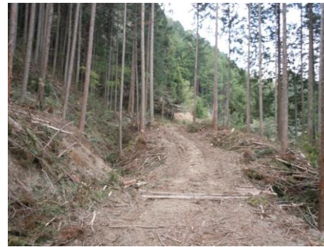
図-3 支線作業道(緊急管理路)
