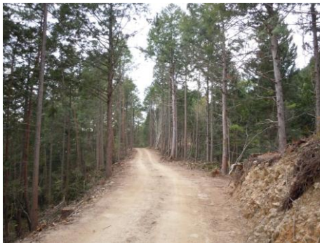
図-2 基幹作業道(中切4号線)
