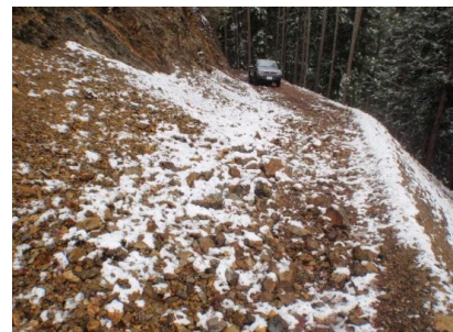
凍み崩れ(車輛通行不能)
