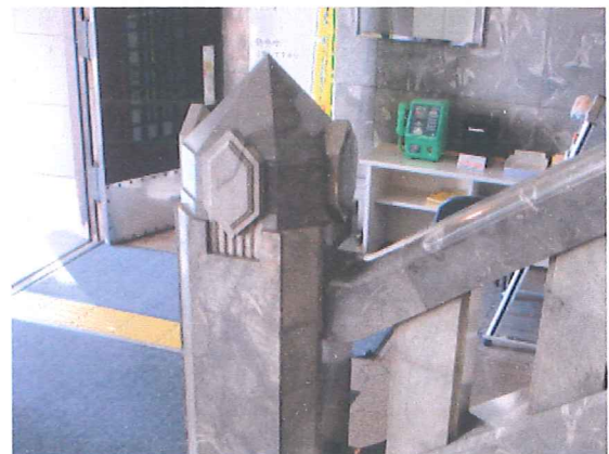
図 3-50 玄関ホール階段親柱
