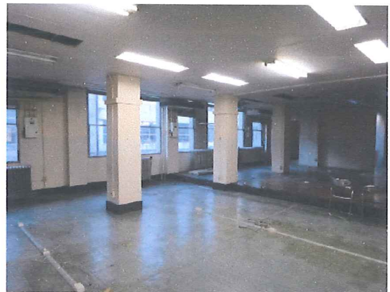
図 3-31 旧議場（柱を追加し 3 階の床スラブが増築されている）
