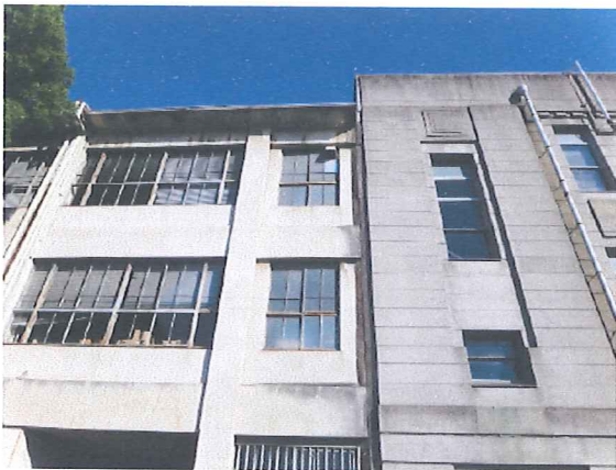
図 3-29 西面、増築部（左側）との連結箇所
