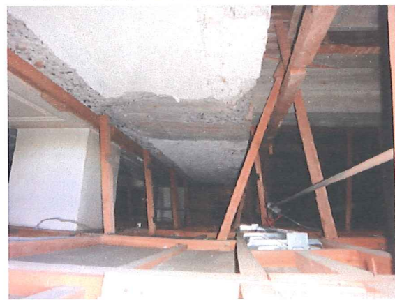
図3-36 旧議場傍聴席躯体の底面とそれを支える柱
