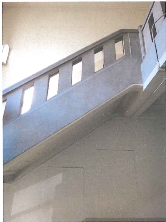
図3-34 開口部の痕跡(北西隅階段の北西2~3階)
