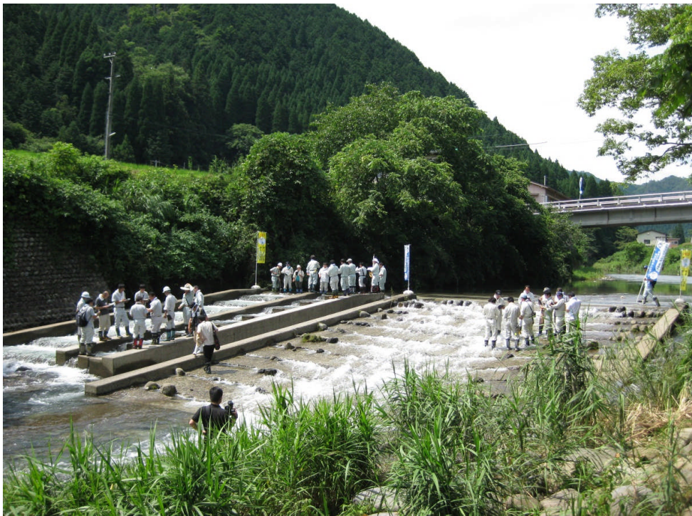
点検状況(魚道下流から上流を望む)
