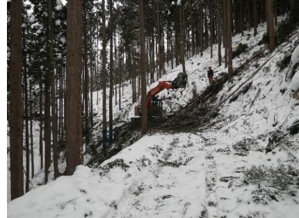
スイングヤーダ作業状況
