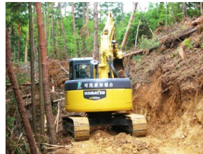
図-3 尾根部を中心とした作業道開設（中切2号線）
