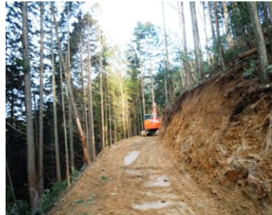
図-9 団地外での作業道開設 (杉洞2号線)
