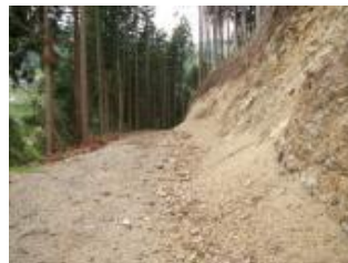
既設作業路崩土調査
