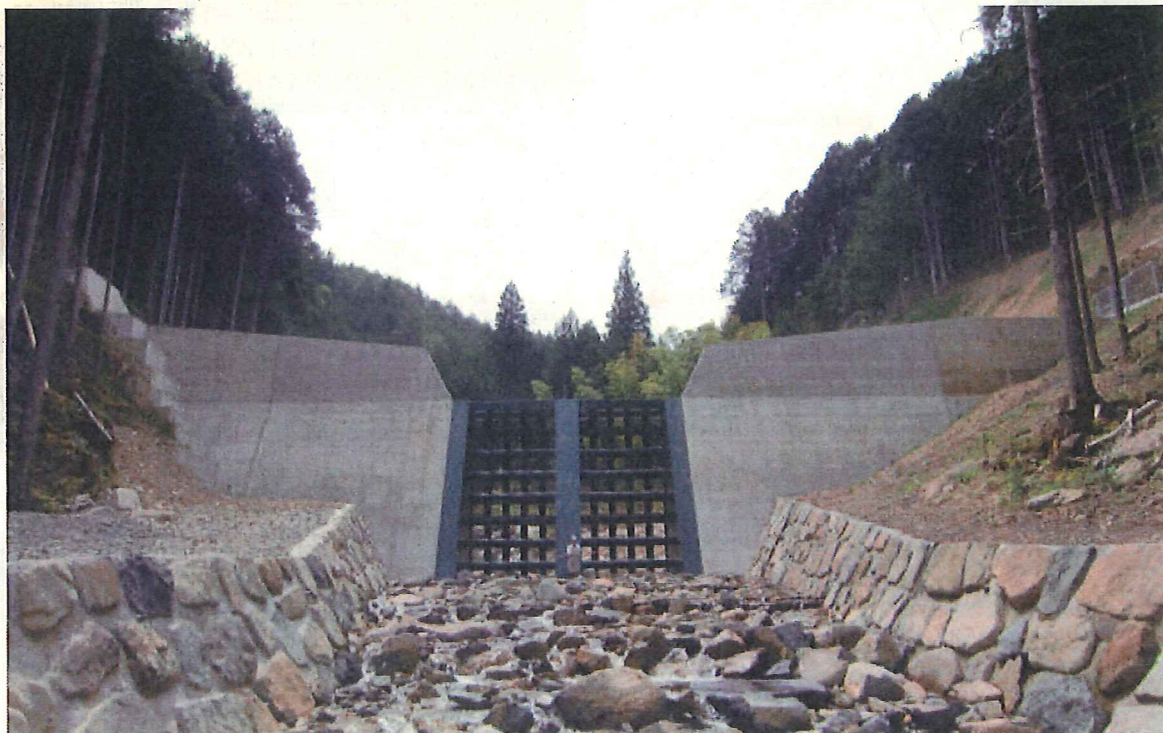
本川 本堤(平成22年完成)
