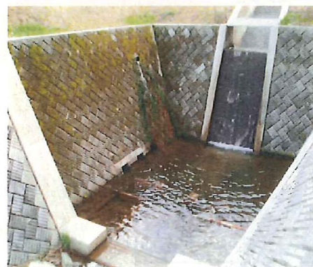
魚巣ブロック・木工沈床（間伐材）
