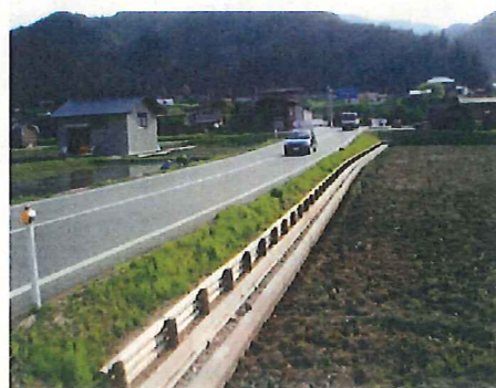
魚巣ブロック・木工沈床（間伐材）
