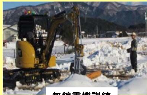
無線重機訓練
