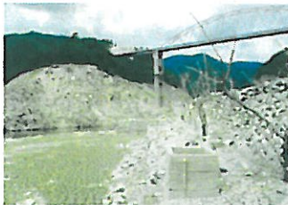
枯渇した岩屋ダム(水資源機構提供)
