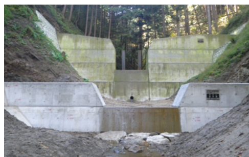
流木捕捉式治山ダム
