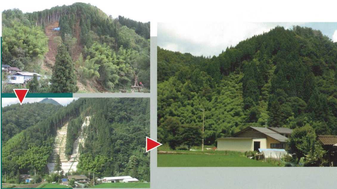
【パンフレット 「岐阜県の治山」より】
