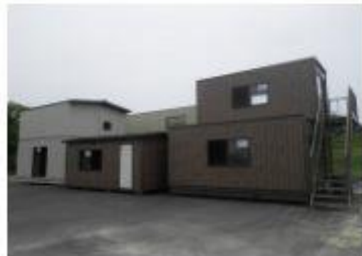
(移動式街区訓練施設)
