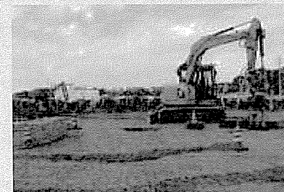
無線重機によるガレキ処理
