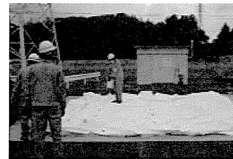
拠点の設営作業
