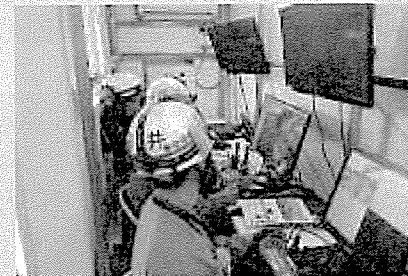
無線重機操作室
