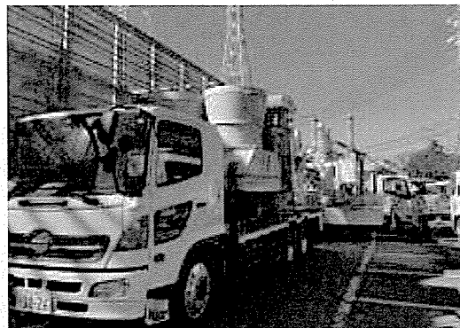
発電所構内に移動用変電設備を設置する訓練
