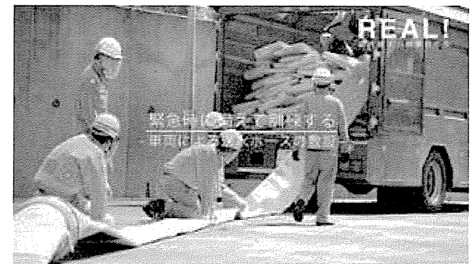
「【訓練7】車両による送水ホースの敷設」篇
