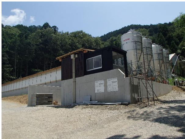
木材と棒鋼によるハイブリット構造
