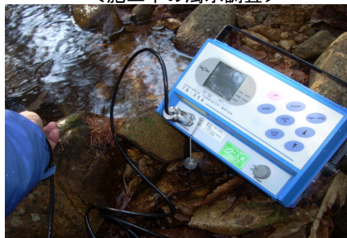
＜施工中の濁水調査＞
