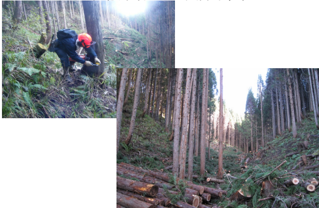
＜建設業者による支障木伐倒＞
