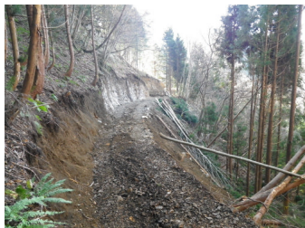
荒切り施工後
