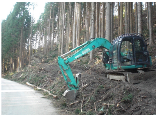
作業道開設状況
