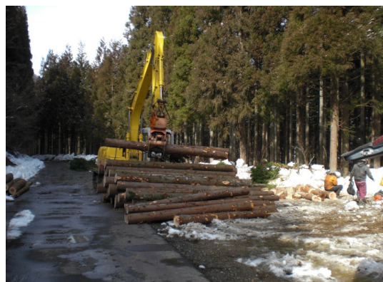
作業道支障木仕分状況
