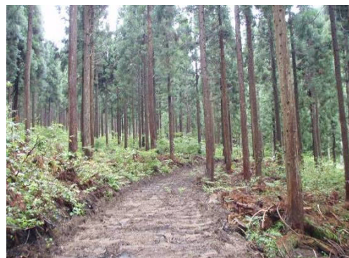
支線(組合自力施工)
