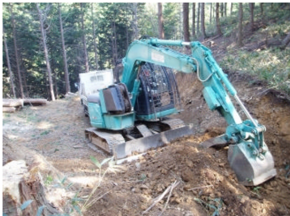
作業道の開設状況
