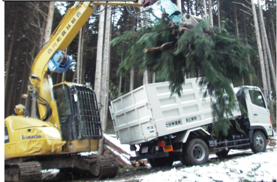
林地残材の搬出実証
