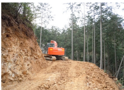
図-7 杉洞地区作業道開設状況
