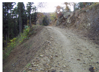
【作業道 重根洞線】 同上補修後
