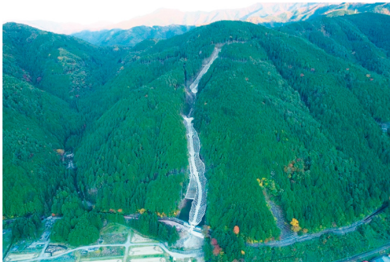
治山施設災害復旧事業 門洞地区工事
