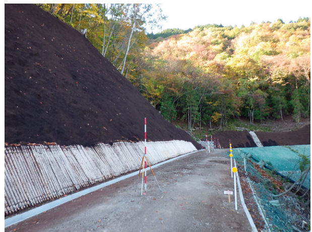
地方創生道整備推進交付金事業 林道二間手～水沢上線（2-2工区）開設工事
