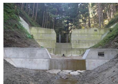
流木捕捉式治山ダム
