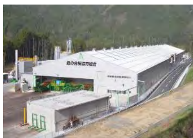
合板工場（中津川市）
