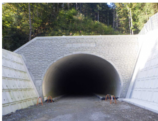
(一)上野関線 大矢田工区 工事状況
