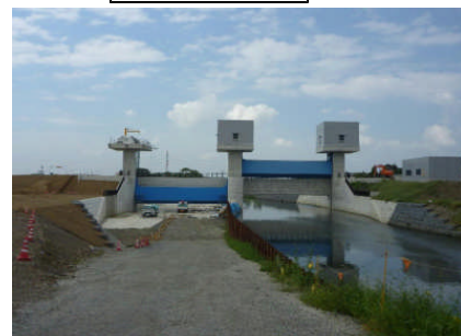
泥川水門施工状況
