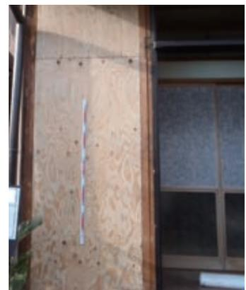
▲構造用合板による壁の補強
