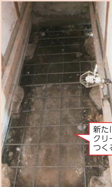
新たに鉄筋コンクリート基礎をつくる
