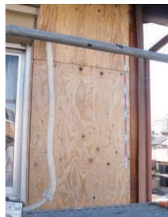
▲ 構造用合板による壁の補強
