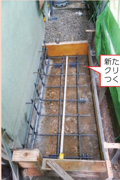
新たに鉄筋コンクリート基礎をつくる
