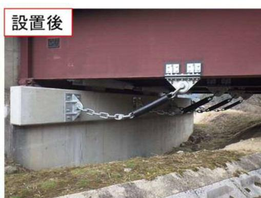
・緩衝チェーンの設置により地震時の落橋を防止します。
