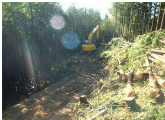
作業道開設状況②
