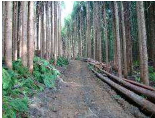
作業道開設状況②
