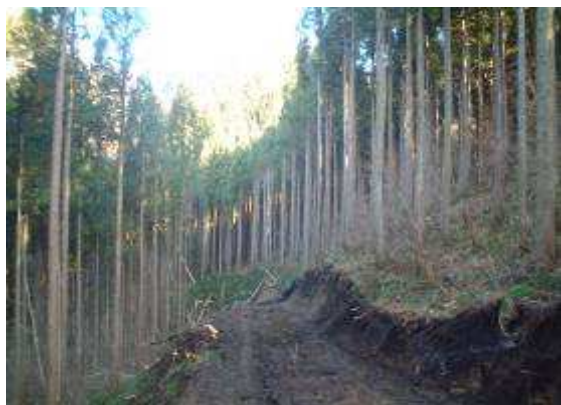
作業道開設状況①
