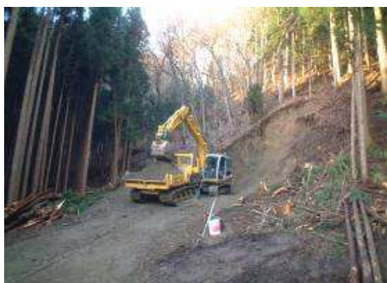
作業道開設状況③
