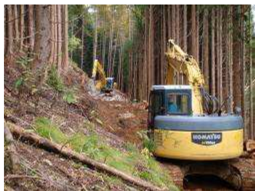
作業道開設状況①
