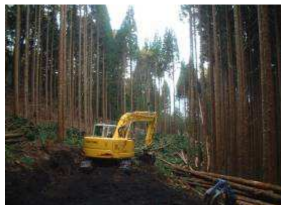
作業道開設状況⑥
