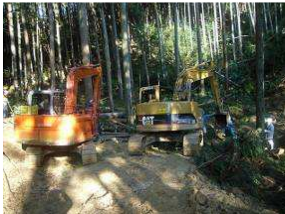
開設中作業道での施業①
