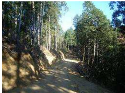
作業道開設状況①
