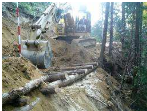
作業道開設状況②
