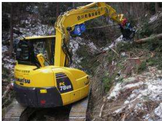
作業道開設状況①
