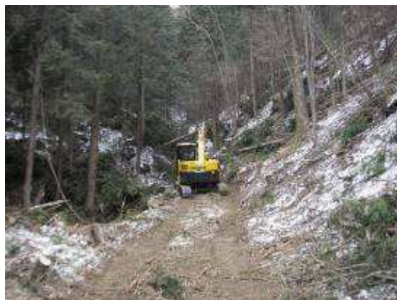
作業道開設状況②
