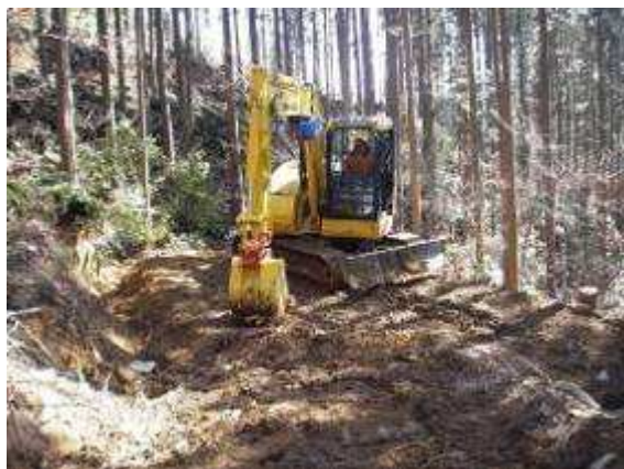
作業道開設状況③
