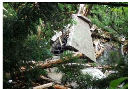
流出した床板
