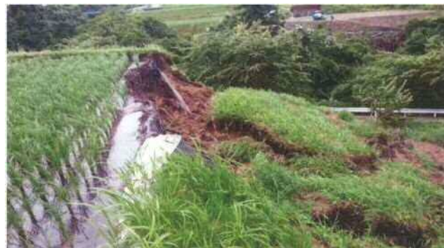
郡上市大和町大間見地内
