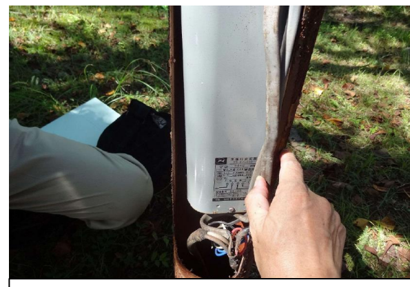
照明灯支柱及び配線点検(花フェスタ)
