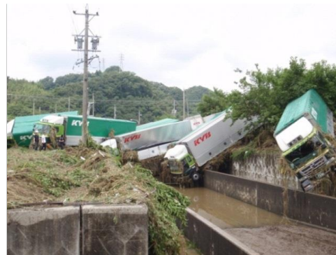
可児市道50号線アンダーパス部 (可児市土田)の状況
