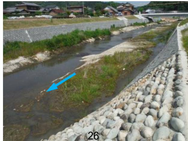
環境に配慮した護岸、水際植生の状況(久々利橋付近)
