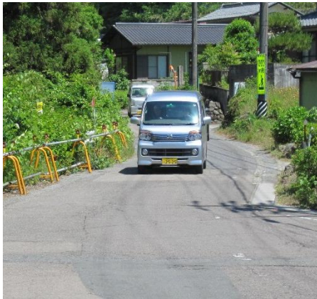
隘路・線形不良箇所
