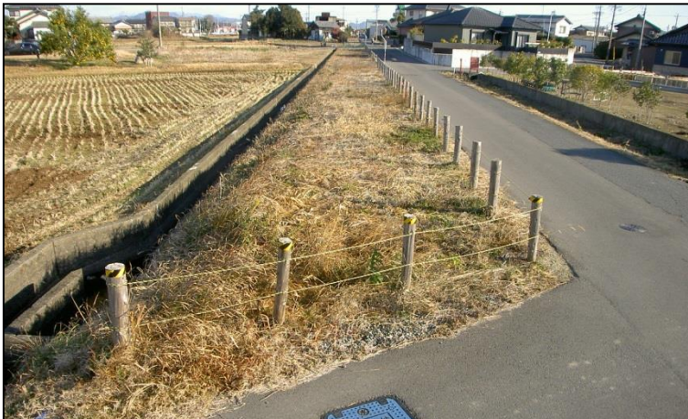
パイプライン施工後
