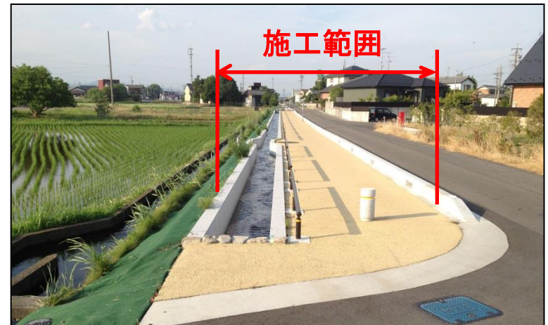
本事業施工後
