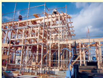
県産材住宅の建設現場
