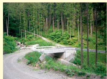
林道と作業道を組み合わせた路網整備
